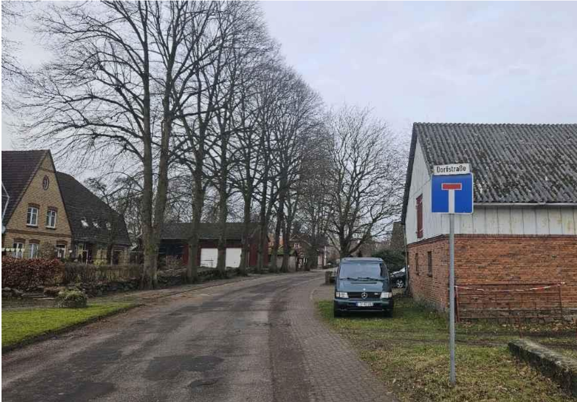
Abbildung 2-8: Blick in die Dorfstraße auf der Höhe der Hausnummer 81
