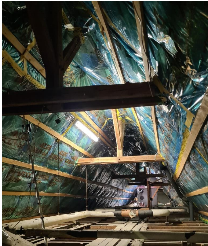
Abbildung 4-20: Dachraum über Wohnungen (Warmdach)
