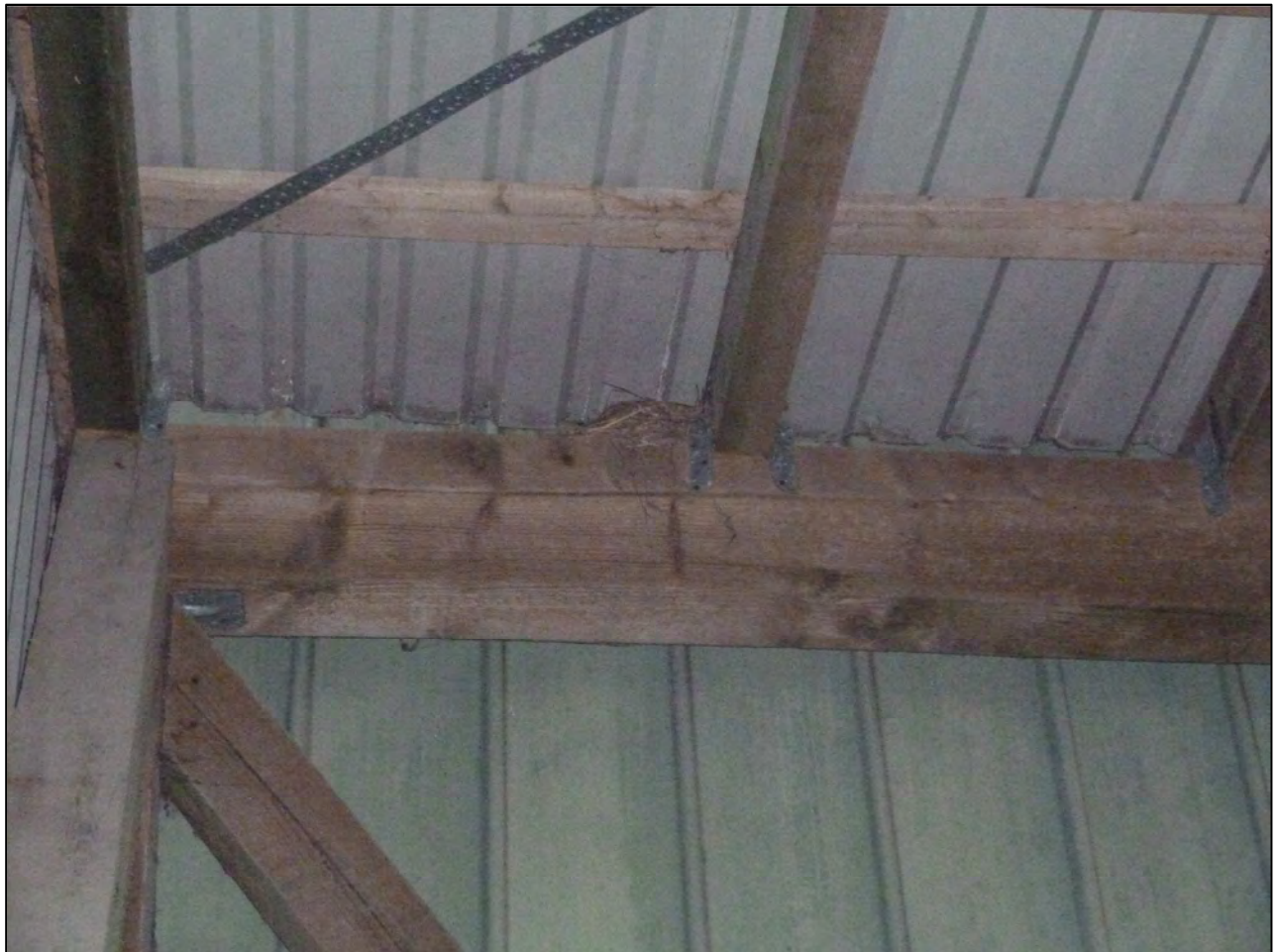
Abbildung 6: Amsele auf Trägerbalken im westlichen Teilstück der Lagerhalle
