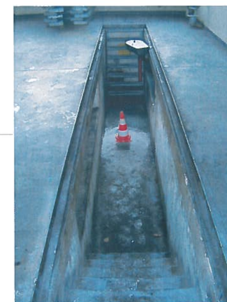
Abb.8: Halle 5, (Inst.-Halle) Kleinbohrung BS 12 (22.05.2006).
