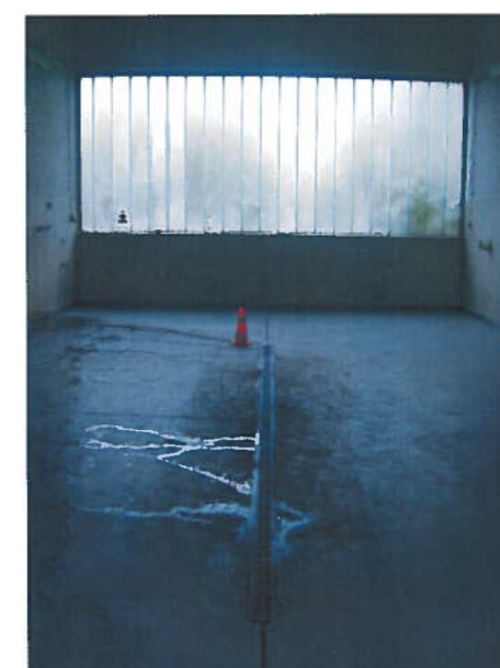
Abb.9: Halle 5, (Waschhalle) Kleinbohrung BS 13 (22.05.2006).
